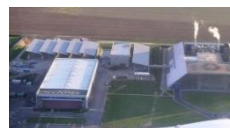
Pic.6 ECONOTRE/ Bessières, Haute-Garonne, France /2001
